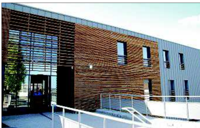
USSEL. D'une superficie de 1.086 m 2 la maison de santé d'Ussel est en ossature bois sur mur maçonné.
